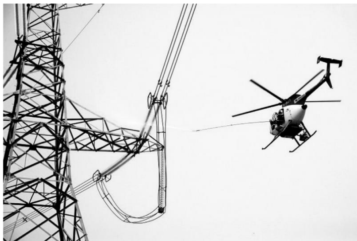
1.4--сурет. Тікұшақтың көмегімен кернеумен тұрған оқшаулағыштарды шаю.
