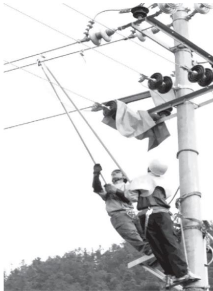
7.4 -сурет. Оқшаулайтын қол қарнағы көмегімен жүктемесіз бұрмалы қоспаларды қосу
