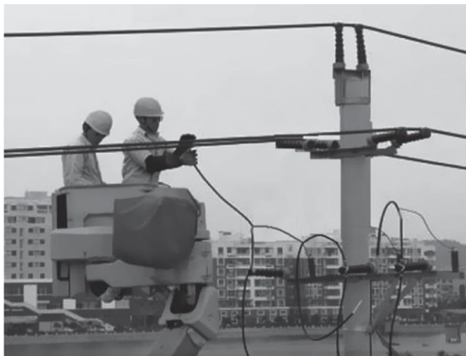
7.2 -сурет. Оқшаулайтын бөлімі бар көтергіш құрылғының көмегімен кернеулі жерде жүктемесіз бұрмалы қоспаларды қосу.
