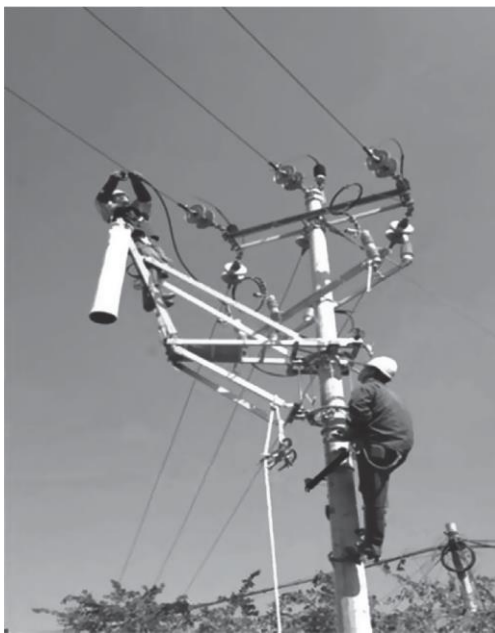
7.3 -сурет. Оқшаулайтын платформаның көмегімен бұрмалы қоспаларды қосу.
