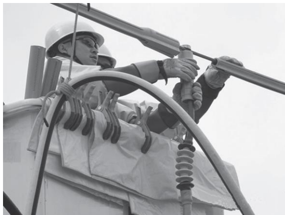
9.25-сурет. Жүктелмеген кабельдік шықпаларды оқшаулағыш буыны бар антенналық құрылғымен қосу.
