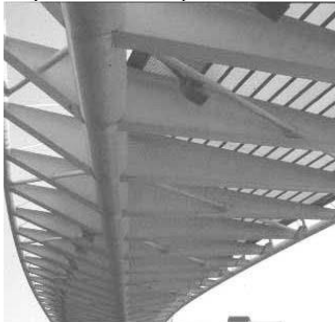
Рисунок 10.1. Пешеходный мост в Бильбао, архитектор Сантьяго Калатрава, фотоснимок из CTICM
