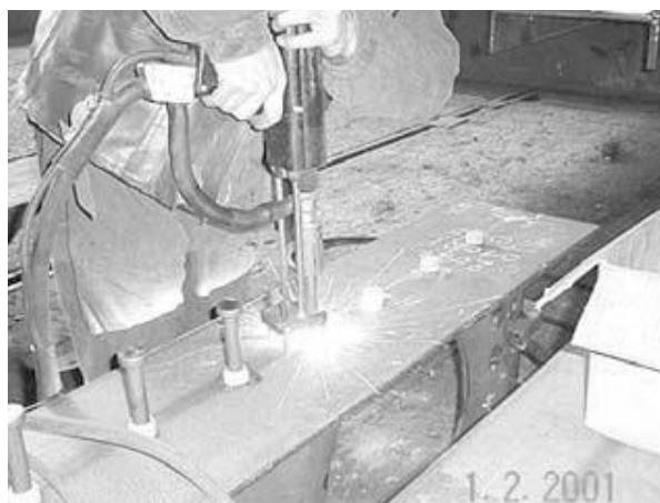
Рисунок 10.5. Приварка штырей: сварка элементов соединения – фотоснимок из Боден-Шатонеф
